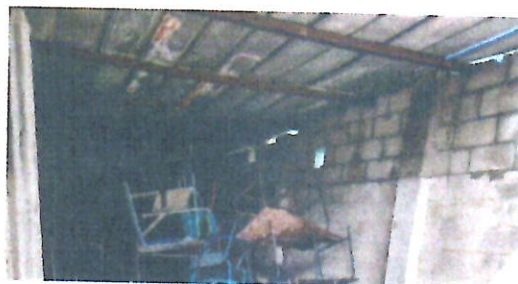
CUBIERTA DE LAMINA Sustitución de lamina, por lamina troquelada calibre 26
