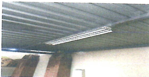
FOTO4:REPARACIÓN DE SISTEMA ELÉCTRICO sustitución de sistemas de iluminación: Lámparas
